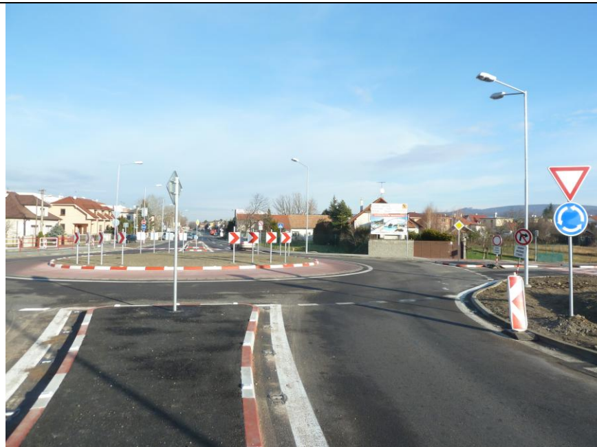
stav po rekonštrukcii, 6.12.2012
