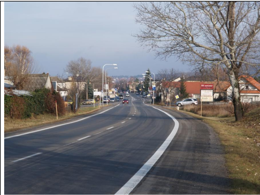
stav pred rekonštrukciou
